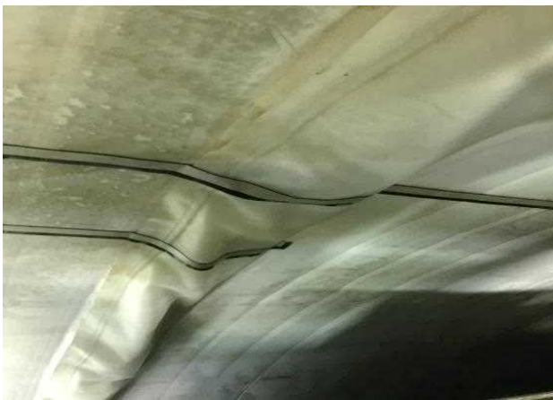
トンネル工での防水シート貼付け例
