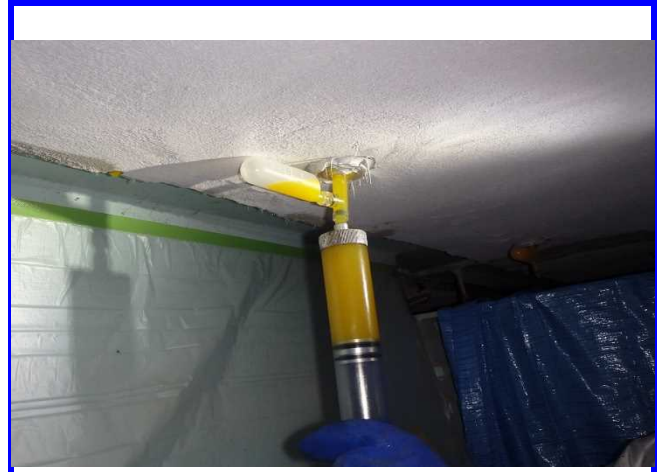
④超低粘度エポキシ樹脂 注入
