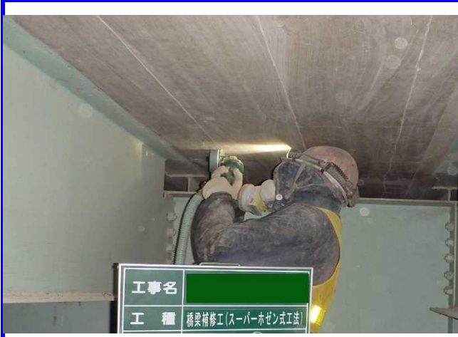
①ケレン後、樹脂導入路設置
