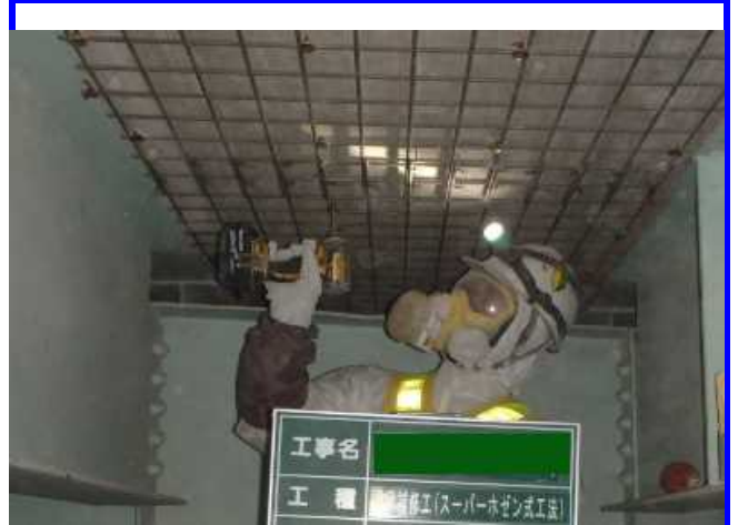
②網鉄筋取付工
