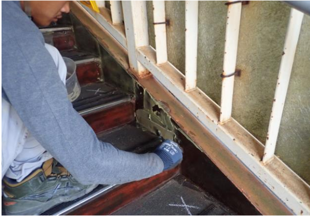
貼付けプライマー塗布状況
