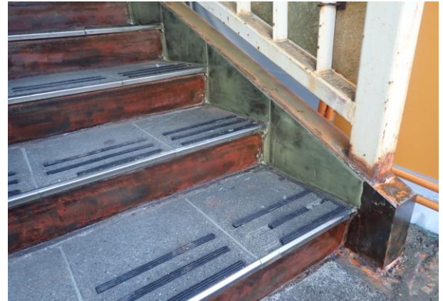
シート貼付け完了
