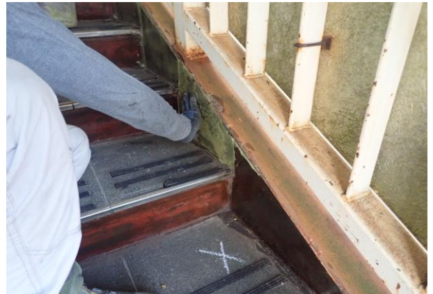
シート貼付け位置合わせ
