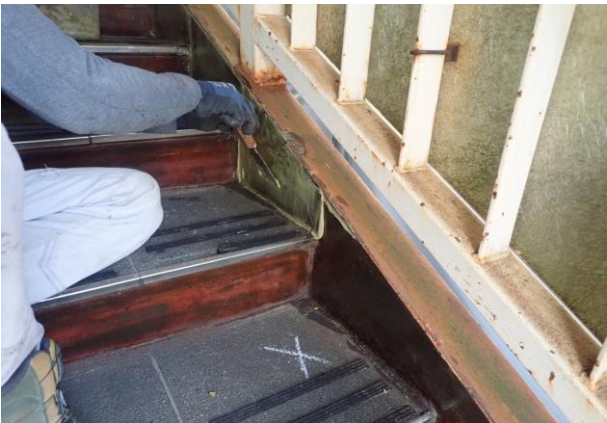
シート脱泡状況
