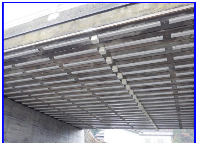
NAKAROD陽極設置完了
