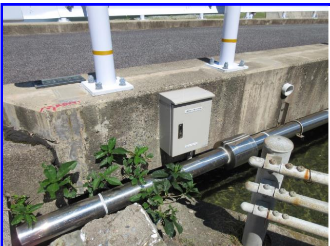
モニタリングボックス設置
