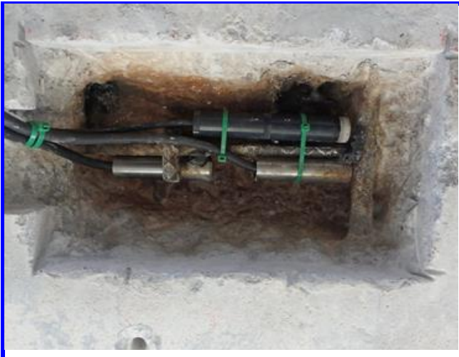
照合電極・端子設置
