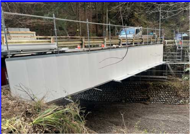
TOBISLIDE 防護柵(朝顔)施工
