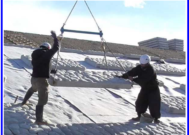
吊り上げ状況①
