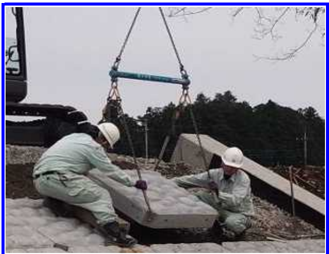
吊り上げ状況③
