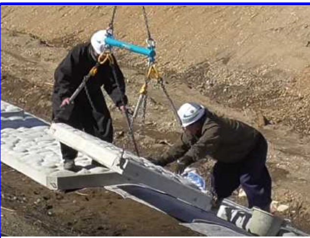
吊り上げ状況②
