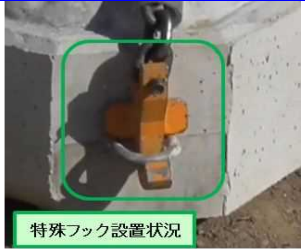
特殊フック設置状況
