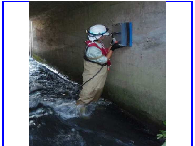
樋門側壁裏空洞探査状況(陸上型装置使用)
