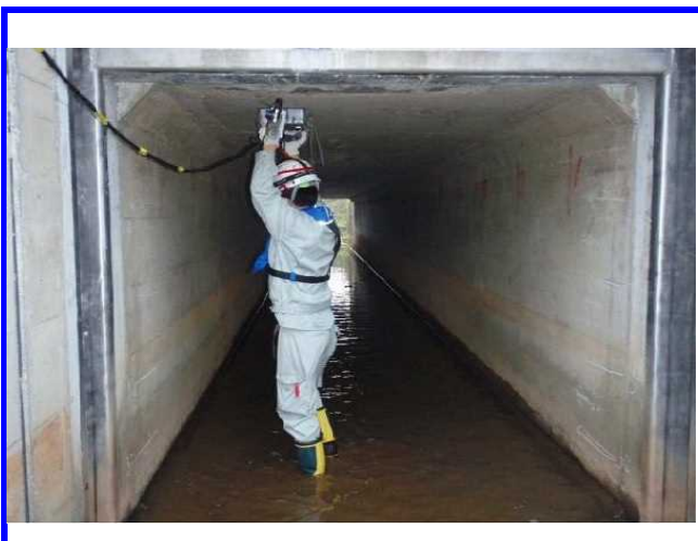
樋門頂版裏空洞探査状況(陸上型装置使用)
