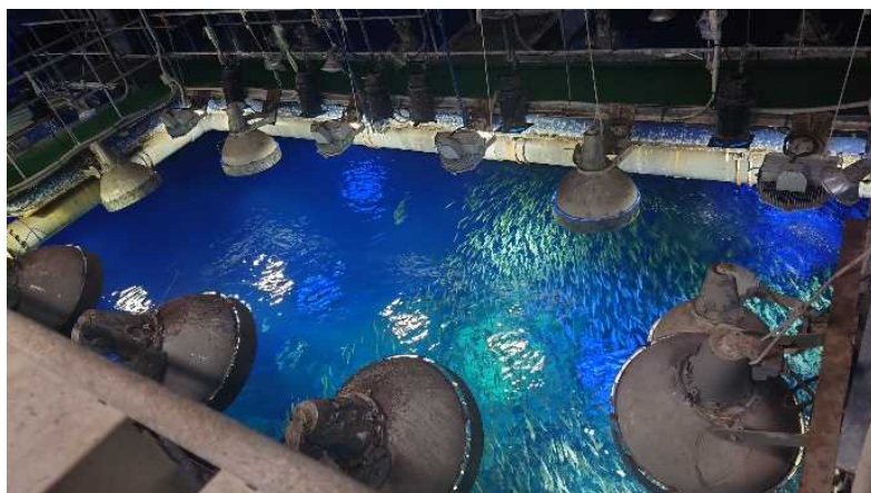
↑ 館内照明設備更新
