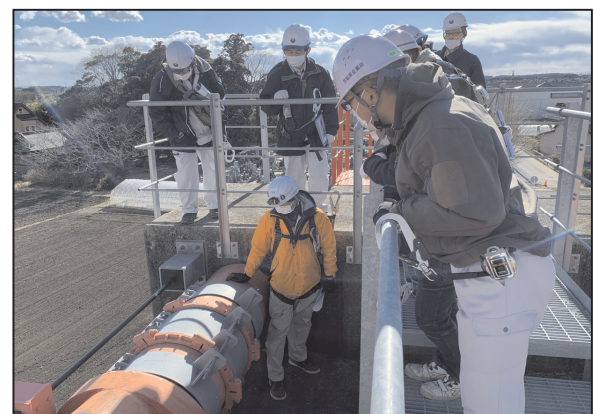
伸縮管点検状況
