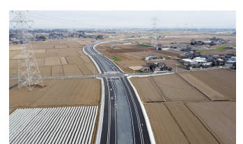
(主) 筑西三和線(筑西幹線道路)
