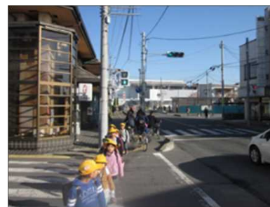
【無電柱化】平友部停車場線
