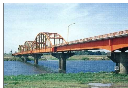
【橋梁耐震化】国道408号長豊橋
