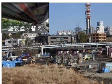
【橋梁修繕】水戸神栖線 梅香高架橋
