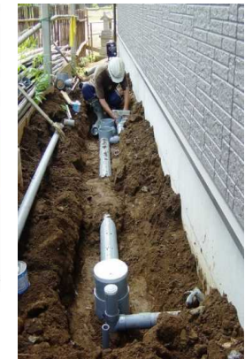
排水設備設置状況
