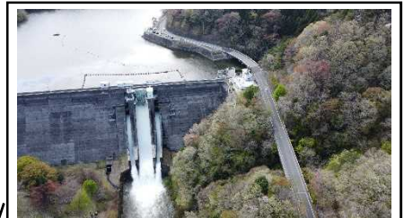
設備更新:花貫ダム(高萩市)
