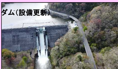
写真-4 花貫ダム (高萩市)
