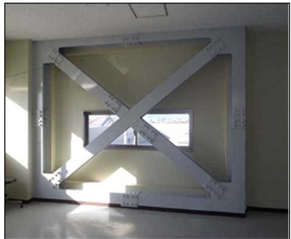
【建築物の耐震補強イメージ・内部】
