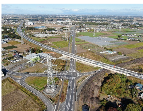
国道354号境岩井バypass【境町】
