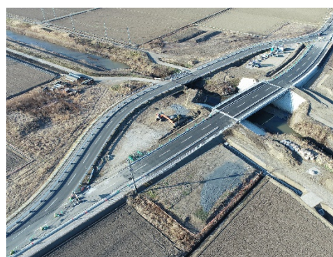
八間堀川（橋梁架替）【常総市】
