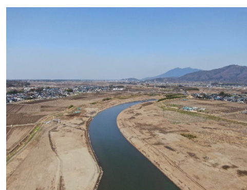
桜川（河道掘削）【土浦市】
