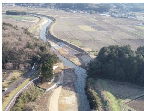
恋瀬川（河道掘削）【石岡市】
