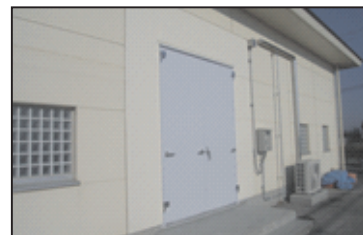
【防水扉の設置】
