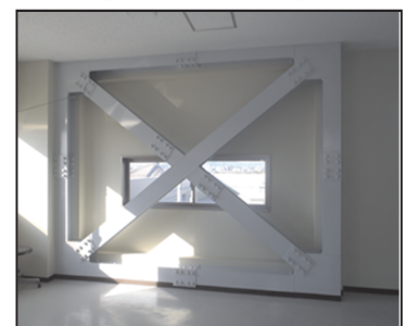
【建築物の耐震補強】
