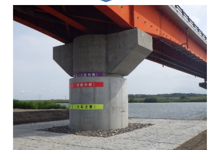
写真5 国道408号長豊橋 (橋梁耐震化)
