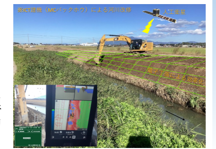
写真4 3次元設計データによる土工
