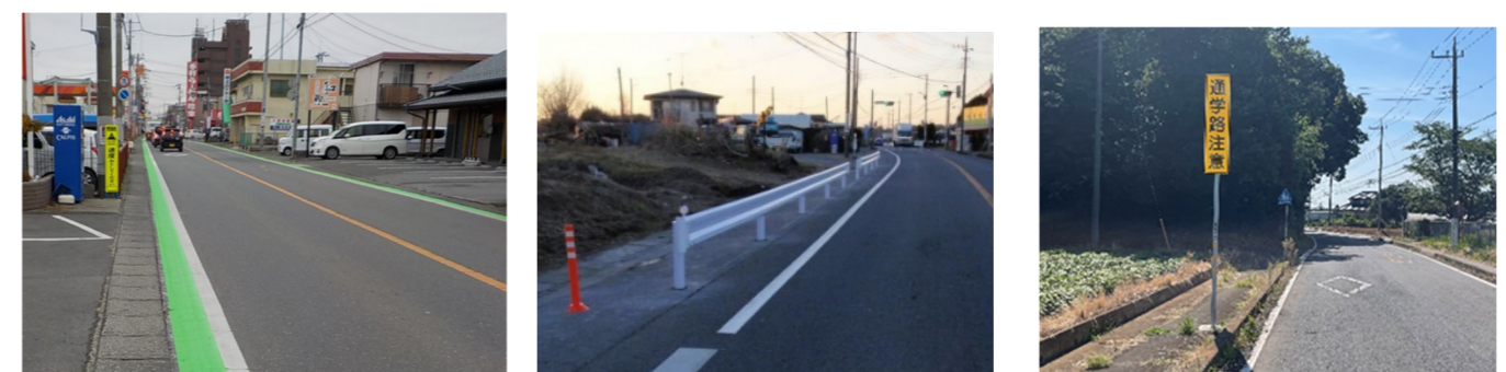
写真5 即効性のある対策の実施例 (左: 路肩カラー化、中央: 防護柵設置、右: 注意喚起看板設置)
