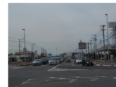
写真4 県道奥野谷知手線 (交差点改良)
