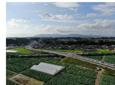
写真1 国道354号土浦バイパス
