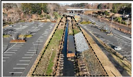
河道掘削: 桜川(水戸市)
