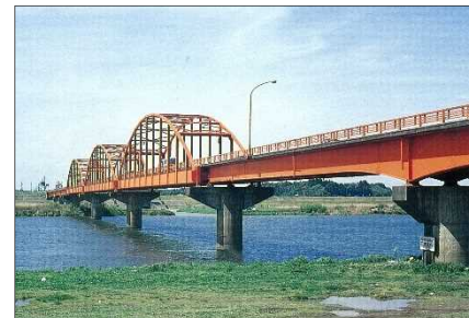
【橋梁耐震化】国道408号長豊橋
