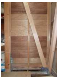
耐震改修工事例
