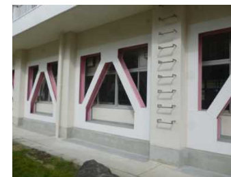
耐震改修工事例
