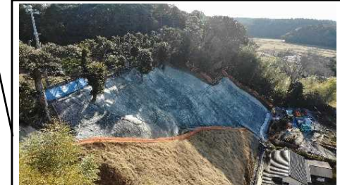
法面对策: 武井1地区(鹿嶋市)
