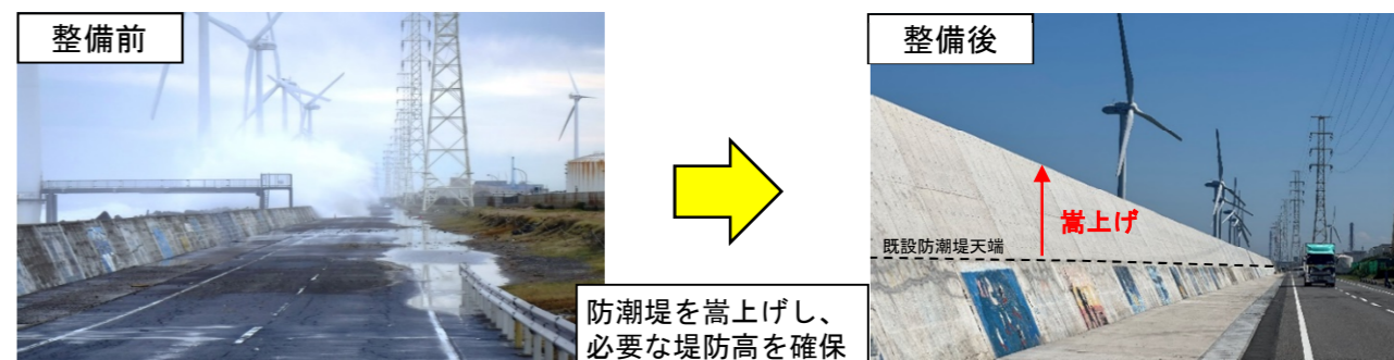
写真5 防潮堤の整備（鹿島港海岸（日川地区））
