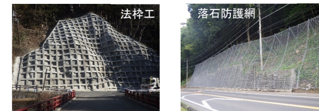
▲写真-4・5 法面対策の例
