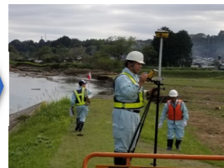
写真2 被害状況調査 (測量設計コンサルタント)
