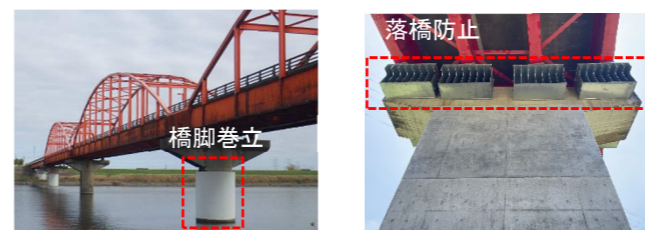
▲写真-2・3 橋梁耐震化の例
