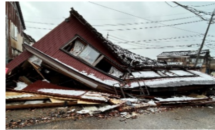
【写真1】令和6年能登半島地震住宅倒壊
