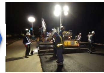
写真3 応急復旧工事 (資機材関係団体、建設業協会等)
