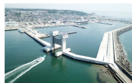
写真3 大洗港区海岸（防潮堤・水門整備）
