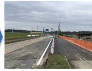
写真4 応急復旧完了
