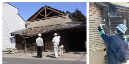
【写真3】応急危険度判定の状況
