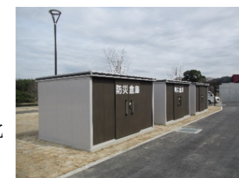
▲写真-6 防災倉庫 （道の駅常陸大宮）
