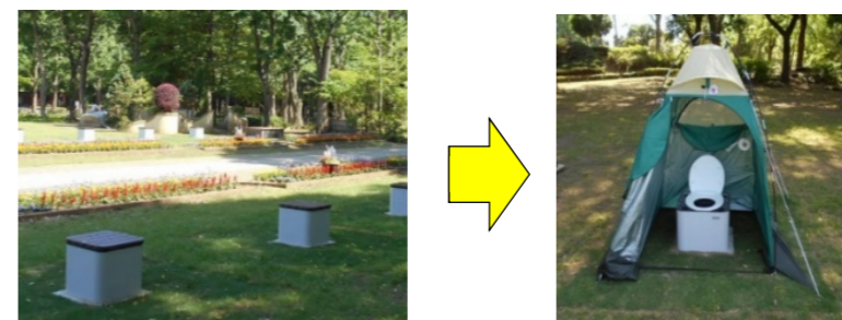
写真4：非常用トイレ（左：通常時 → 右：災害時）
