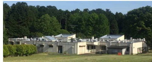
老朽化が進む入所施設（旧棟）
