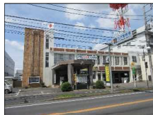
古河警察署現況 (S41年3月築)
