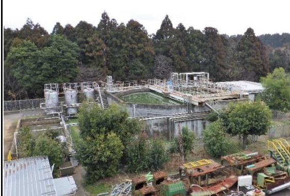
排水処理施設
