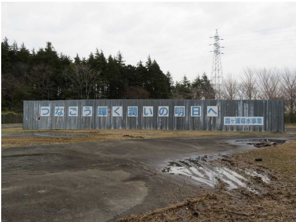
玉里立坑入口
