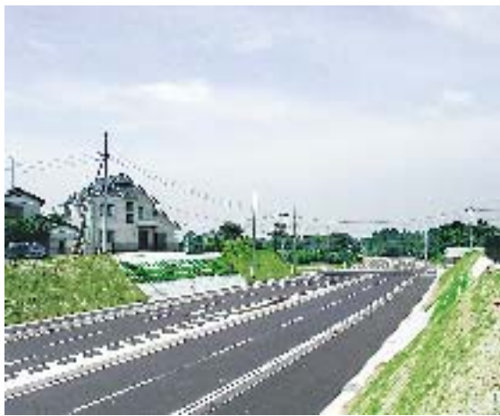
県内各地を結ぶ道路整備
