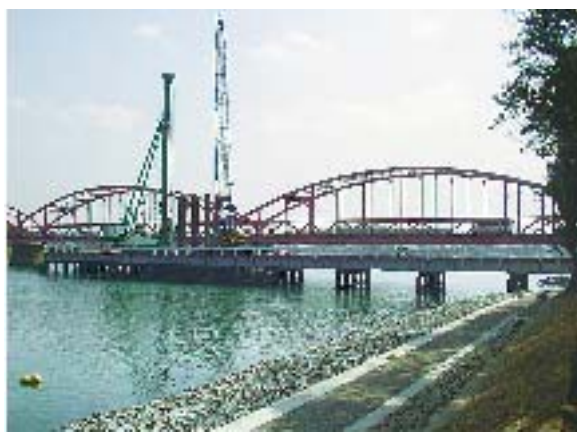
建設中の湊大橋
