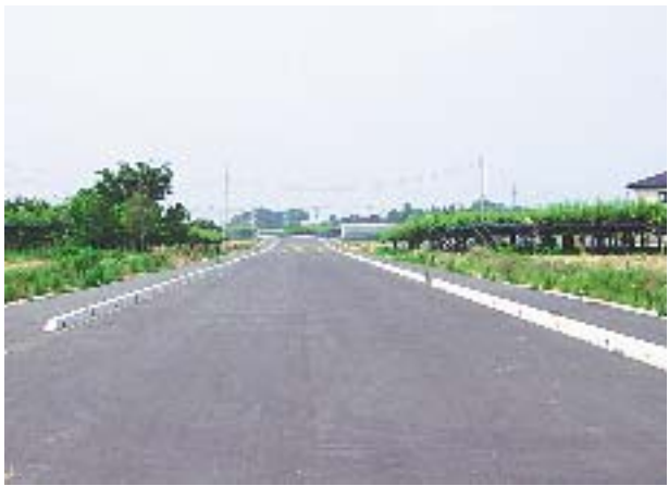
開通間近な下館三和線開城バイパス(筑西幹線道路)
