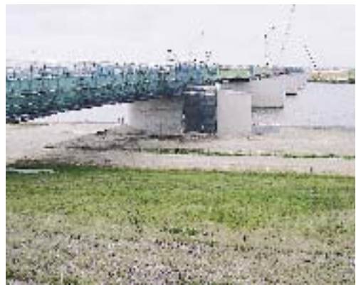
百里飛行場開港にあわせて工事が進められる東関東
