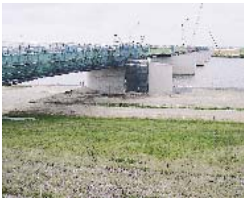
百里飛行場開港にあわせて工事が進められる東関道
