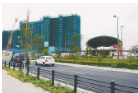
整備が進むTX沿線(みらい平駅前)
