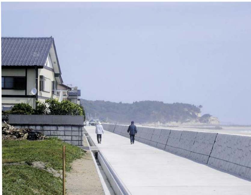
護岸工事後の有明海岸(高萩市)
