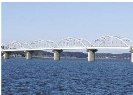
補修中の橋りょう(北浦大橋)
