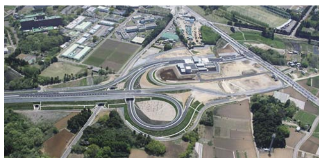
今後の早期整備が見込まれる圏央道(つくば中央IC)
