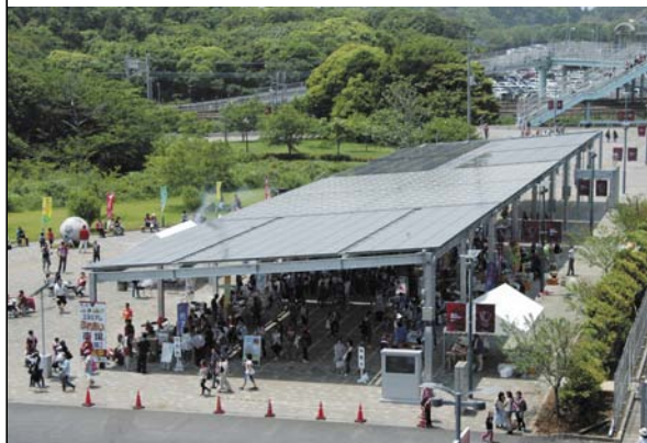
スタジアム敷地内に設置された太陽光発電パネルの屋根付き通路
