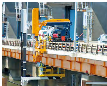
道路施設の点検状況(写真は常陸川大橋(神栖市))
