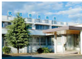
整理統合が望まれる筑西市市民病院
