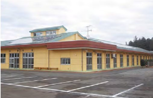
太陽光発電設備を設置した福祉避難所(石岡市)
