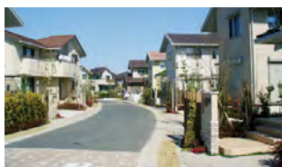
陽光台のまち並み(つくばみらい市)
