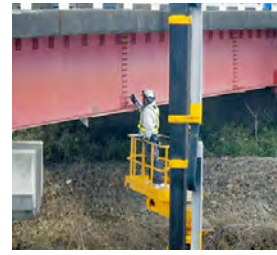
橋の点検の様子
