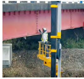
橋の点検の様子
