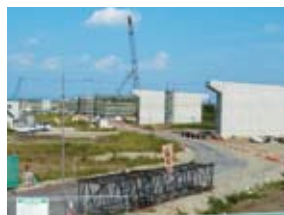
建設中の圏央道常総IC 周辺の様子(常総市)
