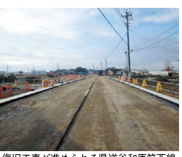
復旧工事が進められる県道谷和原筑西線(常総市三坂町平成27年12月15日現在)
