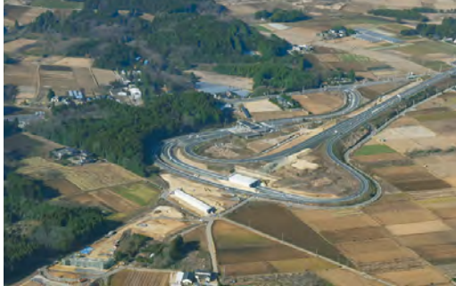
茨城空港北IC(茨城町)付近の整備状況(東日本高速道路(株)提供)
