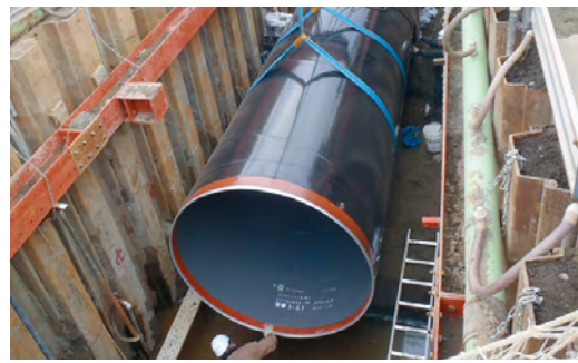
耐震性を有する水道管の敷設状況
