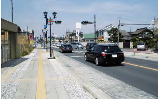
無電柱化された都市計画道路辺田本町線(坂東市辺田)
