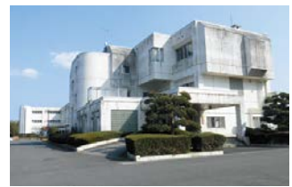
県立消防学校(茨城町)
