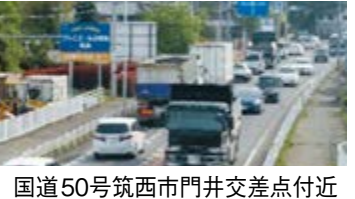
国道50号筑西市門井交差点付近
