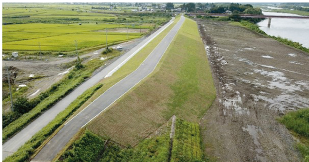
復旧した那珂川の堤防(那珂市下江戸地区)
