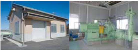
揚水機場などの農業水利施設
