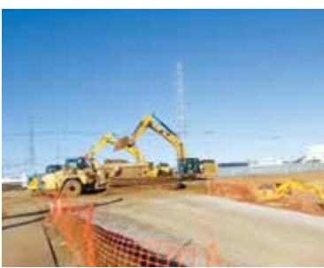
着々と工事が進む圏央道インターパークつくばみらい
