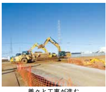
着々と工事が進む圏央道インターパークつくばみらい
