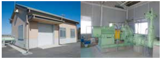
揚水機場などの農業水利施設
