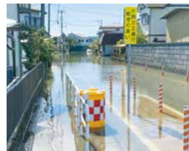
令和5年梅雨前線による大雨被害の状況(取手市)
