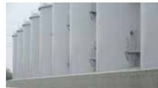
処理水タンク(福島第一原子力発電所)
