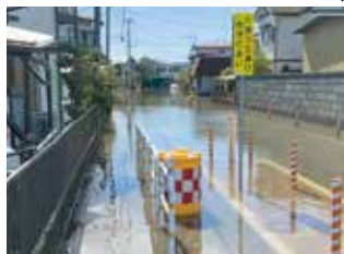
令和5年梅雨前線による大雨被害の状況(取手市)
