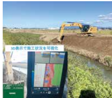
ICT建設機械を活用した省人化施工
