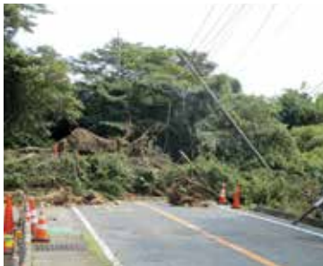
令和5年台風第13号による大雨被害の様子(日立市)
