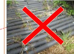
転がし配線は危険です。配管等を地中に埋めたり、コンクリートなどで固めることにより、ケーブル周りを強化。引き抜けない対策をすることで、犯行を防ぎます。
