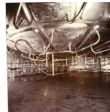
高放射性廃液貯槽 (V33) 下部
