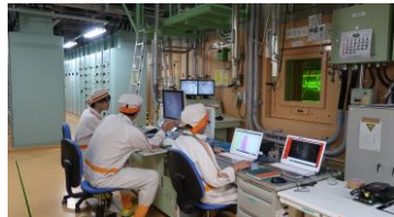
残留ガラス除去作業
