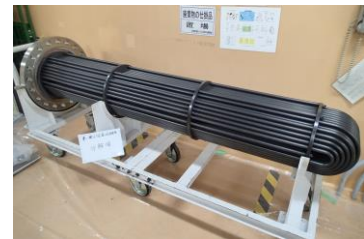
蒸気発生器の点検整備
