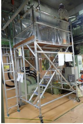
セル内へのケーブル挿入作業
