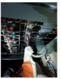
③給水用ホース接続
