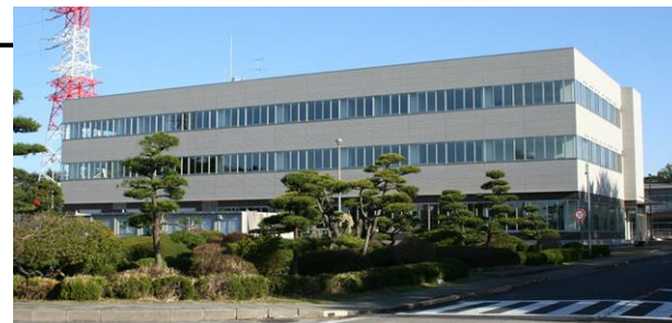
緊急時対策所
